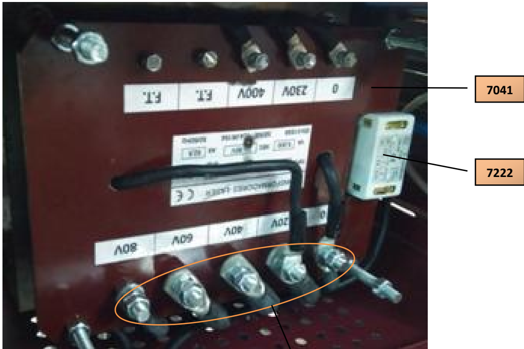
Ejemplo de conexión de transformador 6000VA
