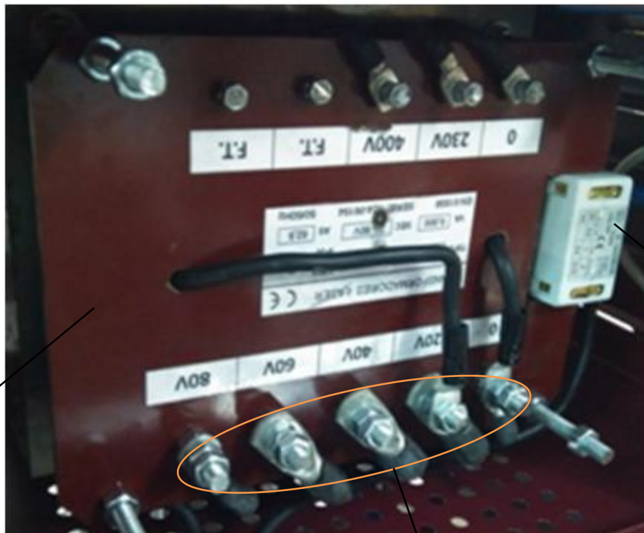
Exemplo de conexão transformador 5000 VA
