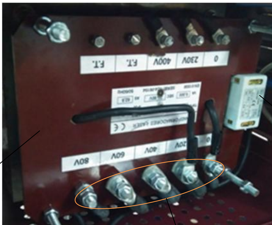
Exemplo de conexão transformador 5000 VA
